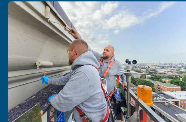
Mit Spezialfarbe wurden 1.300 qm Gesims dreimal gestrichen.
