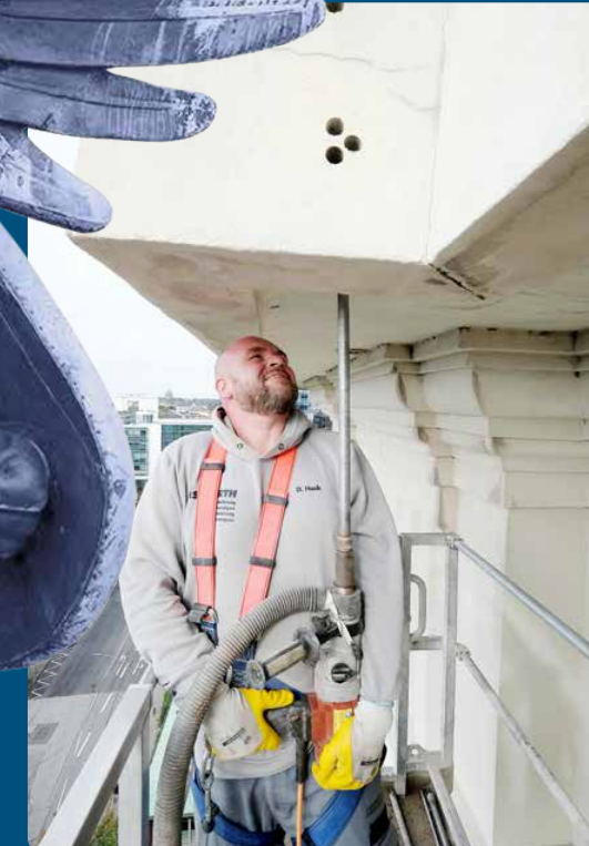
Bis zu 1,50 Meter lange Stahlstangen stabilisieren nun das Gesims. Dafür mussten 150 Bohrungen gemacht werden.
