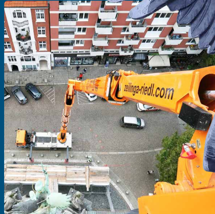
Auf einem Hubsteiger arbeiten die Bauarbeiter bei Wind und Wetter in 40 Metern Höhe.
