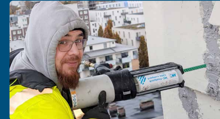
Mehr als 200 große und kleine Risse wurden mit Spezialharz verpresst.
